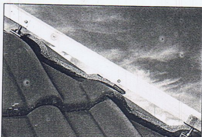
13. Gratlattenverlegung analog Bild 1-6.
